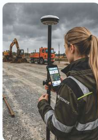
Precizna RTK mjerenja na terenu
