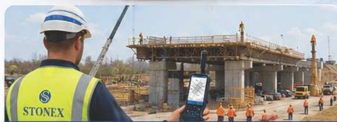
Precizna RTK mjerenja na gradilištima
